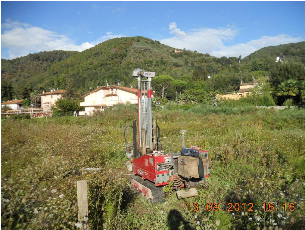
Figura 1: Prova penetrometrica CPT1
