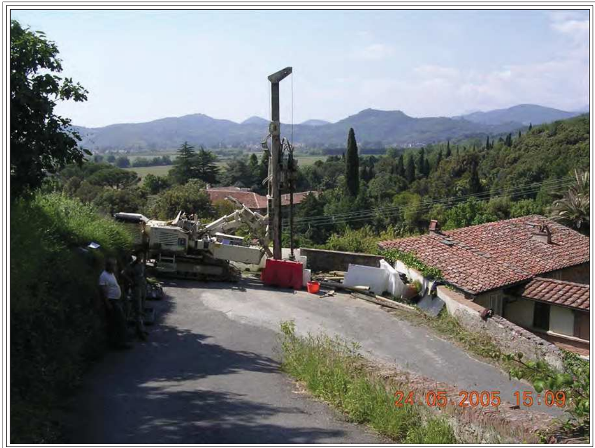
Ubicazione sondaggio S1
