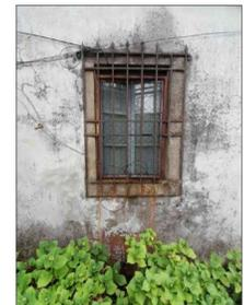
Le finestre saranno ridimensionate in adeguamento alle normative per il rispetto delle superfici finestrate. Esse verranno proposte con caratteristiche analoghe all'esistente ovvero del tipo alla Toscana.
