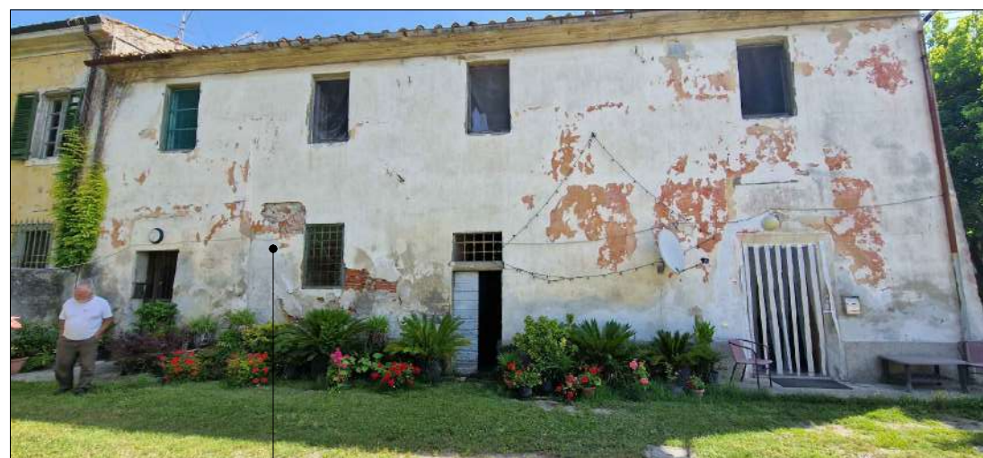
Presenza di un possibile precedente arco murato
