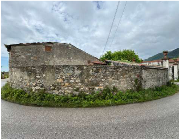
Vista del fabbricato dalla strada. La muratura della recinzione si raccorda con quella del fabbricato. Da questo lato sono maggiormente evidenti i distacchi dell'intonaco.
