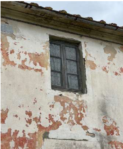
Le finestre sono di legno alla toscana con scuri interni. Quella al piano terra presenta la tradizionale inferriata eseguita con ferro piatto e finitura degli elementi verticali a punta di lancia.
