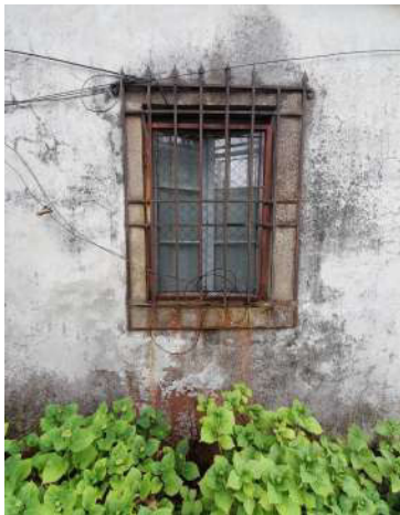
Porte e finestre di legno alla toscana, tipiche dei fabbricati rurali. La finestra presenta la tradizionale inferriata eseguita con ferro piatto e finitura degli elementi verticali a punta di lancia.
