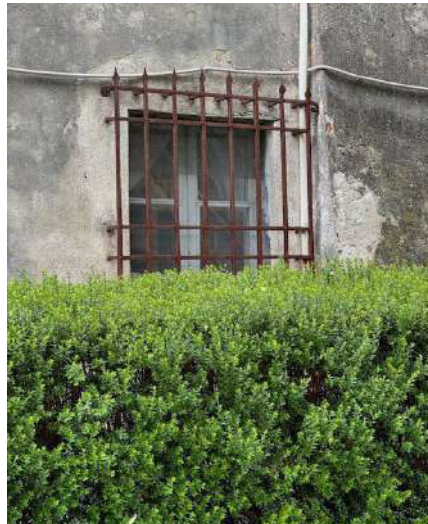
Le finestre sono di legno alla toscana con scuri interni. Quella al piano terra presenta la tradizionale inferriata eseguita con ferro piatto e finitura degli elementi verticali a punta di lancia.
