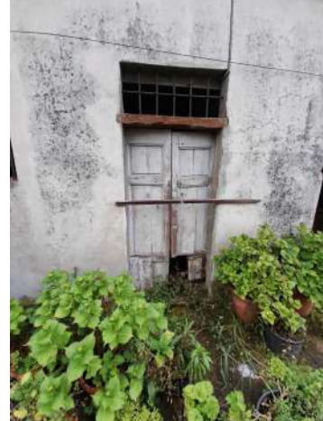
Porte e finestre di legno alla toscana, tipiche dei fabbricati rurali. La finestra presenta la tradizionale inferriata eseguita con ferro piatto e finitura degli elementi verticali a punta di lancia.
