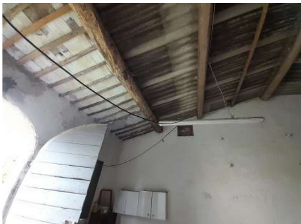
Interno del magazzino copertura di legno, travi travicelli e cotto, pavimentazione di cemento eseguita direttamente sul terreno.
