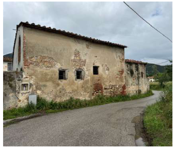
Vista del fabbricato dalla strada. La muratura della recinzione si raccorda con quella del fabbricato. Da questo lato sono maggiormente evidenti i distacchi dell'intonaco.
