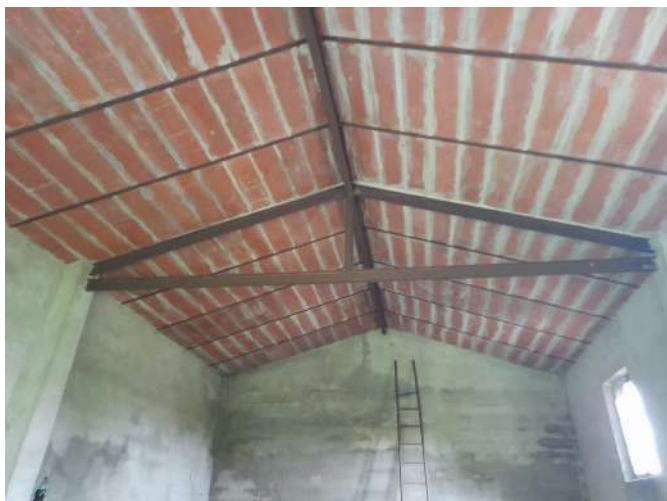
Particolari interni della pavimentazione di cemento e della copertura in ferro e tabelle di cotto.
