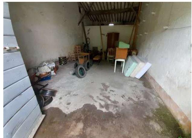
Interno del magazzino copertura di legno, travi travicelli e cotto, pavimentazione di cemento eseguita direttamente sul terreno.
