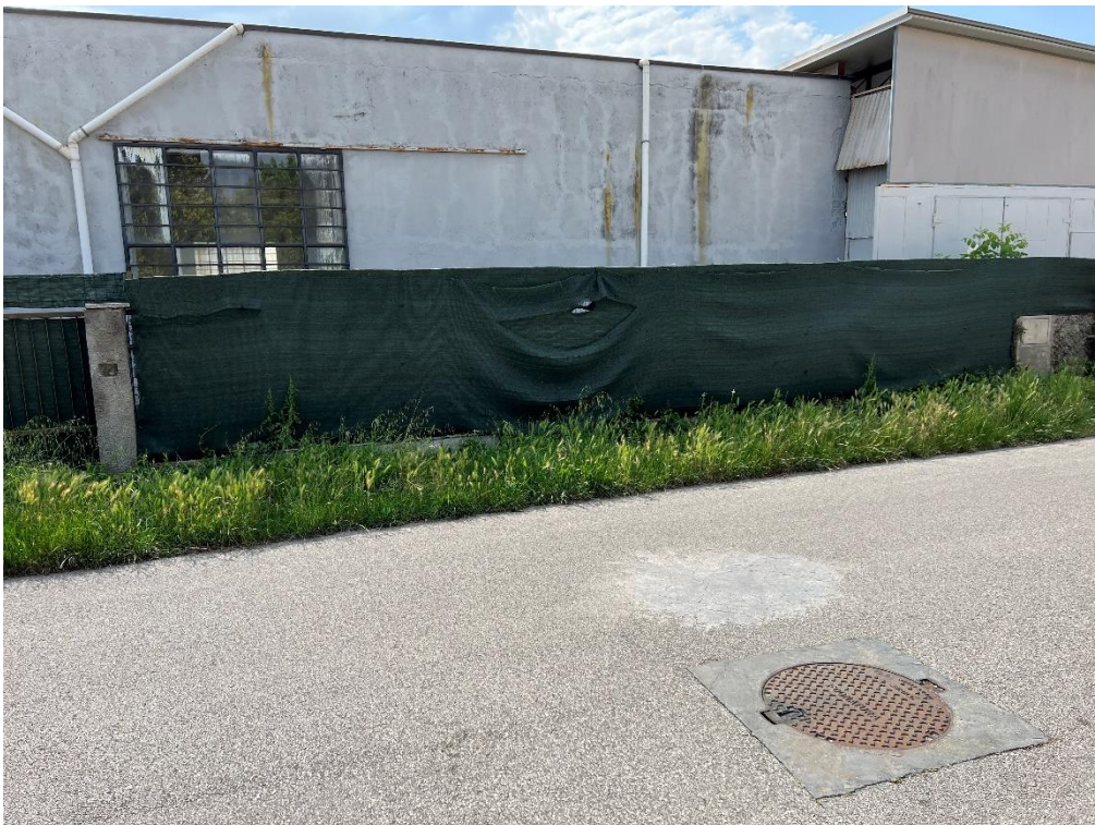
Fognatura lungo via via Ciardi
