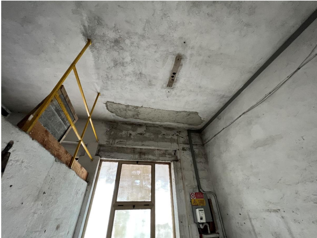
FIG.13 - foto interna Ex Carrozzeria Colombini – edificio principale
