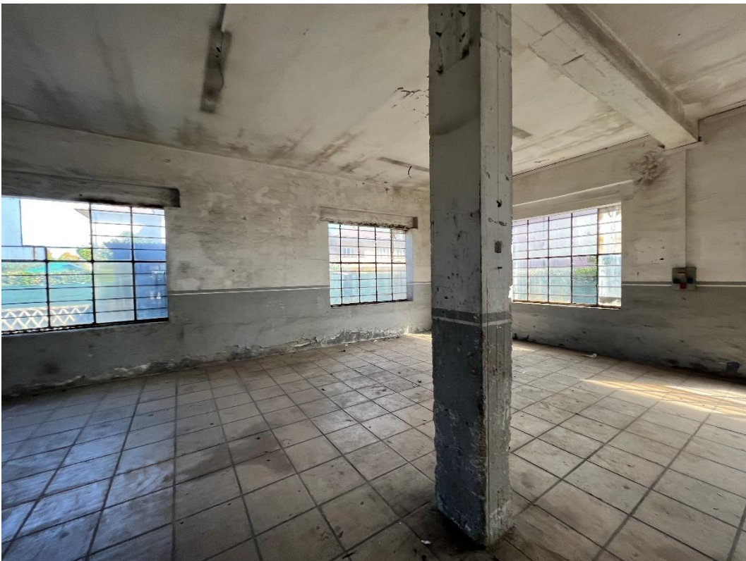
FIG.12 - foto interna Ex Carrozzeria Colombini – edificio principale
