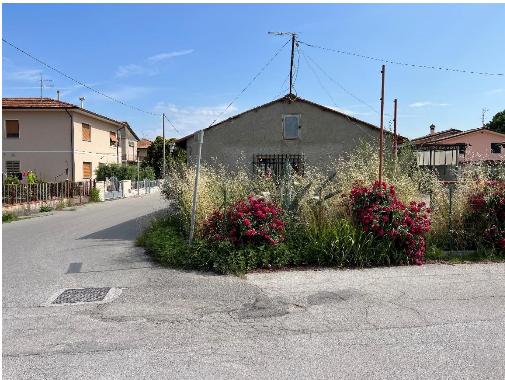
Fognatura, acquedotto e linea telefonica lungo via L. Pasteur via Ciardi
