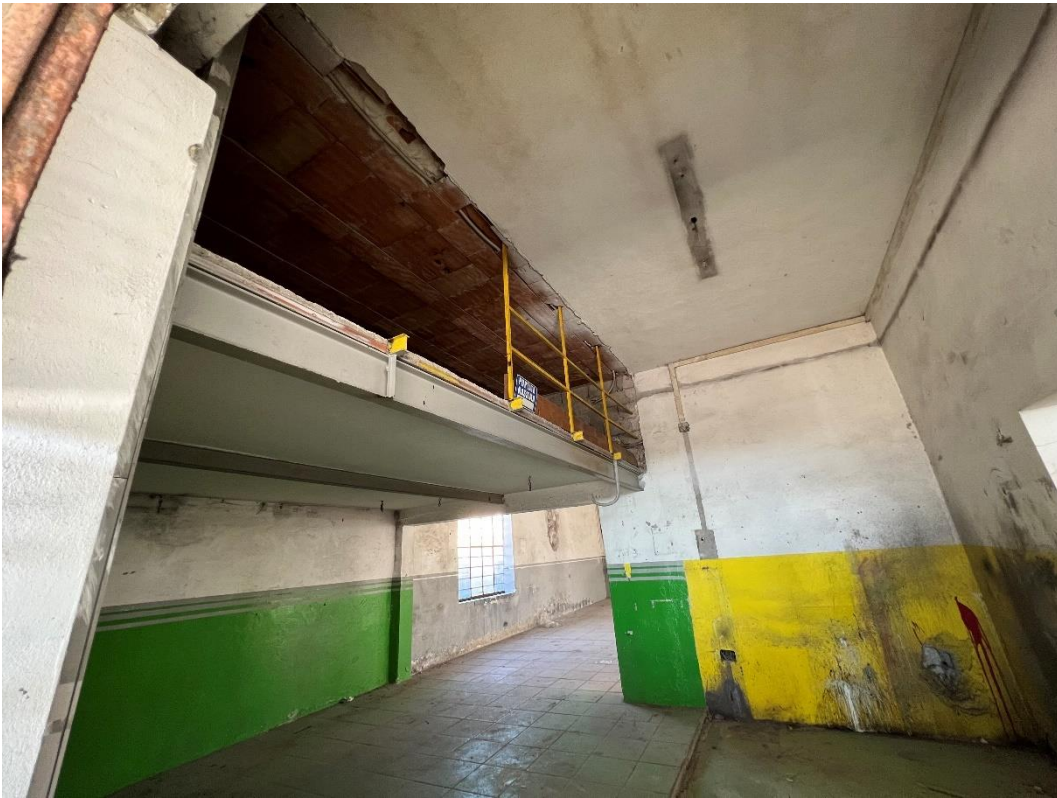
FIG.11 - foto interna Ex Carrozzeria Colombini – edificio principale
