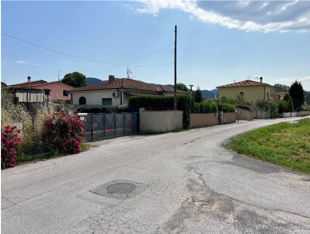
Fognatura, acquedotto e linea telefonica lungo via L. Pasteur
