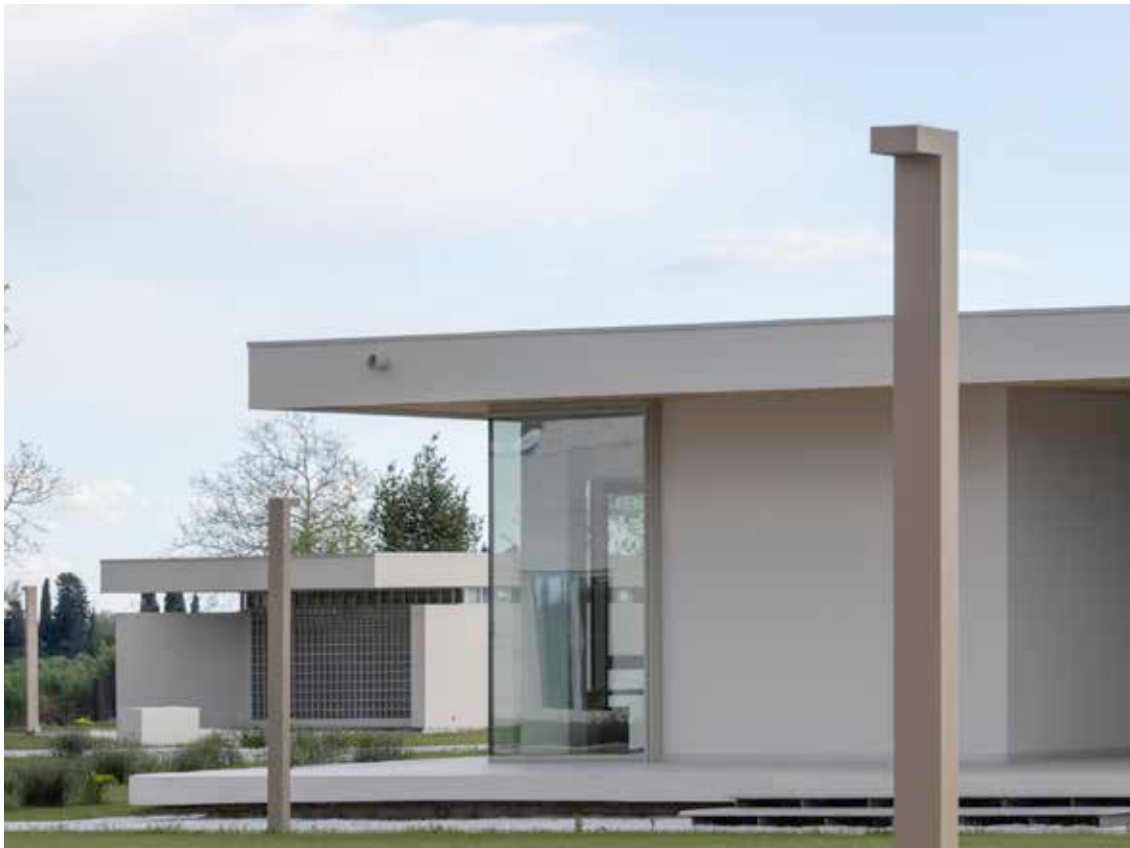
vista di dettagli con lo sfondo della casa del custode e in primo piano l'ala nord dell'edificio direzionale
