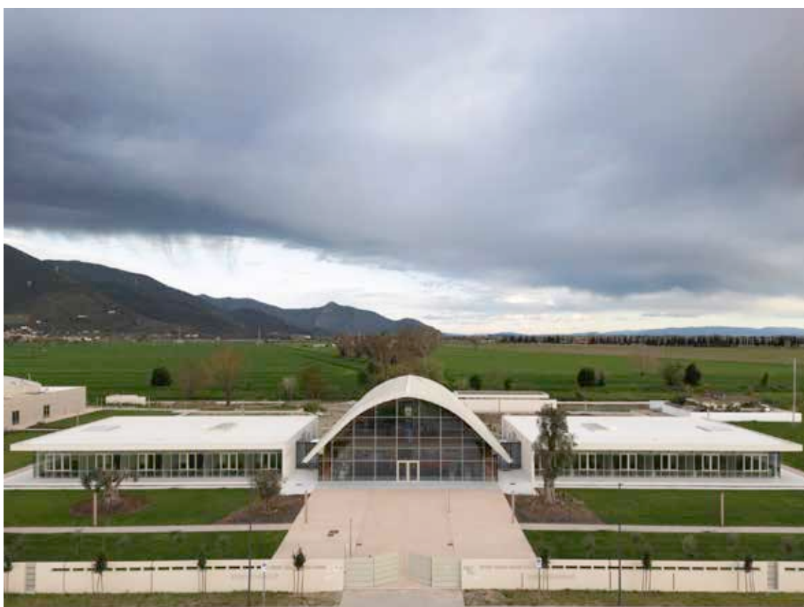
Vista aerea verso l'ingresso dell'edificio direzionale
