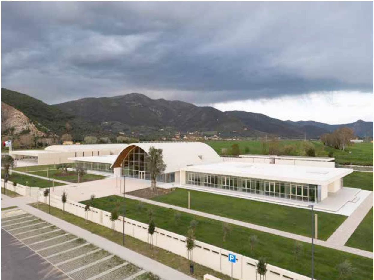
vista aerea verso est; in primo piano l'edificio direzionale e sulla sinistra l'edificio polivalente. Sullo sfondo la casa del custode
