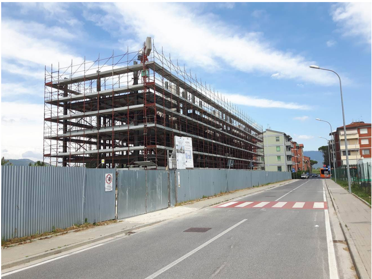
Figura 37 Cantiere del nuovo edificio residenziale (giugno 2020)
